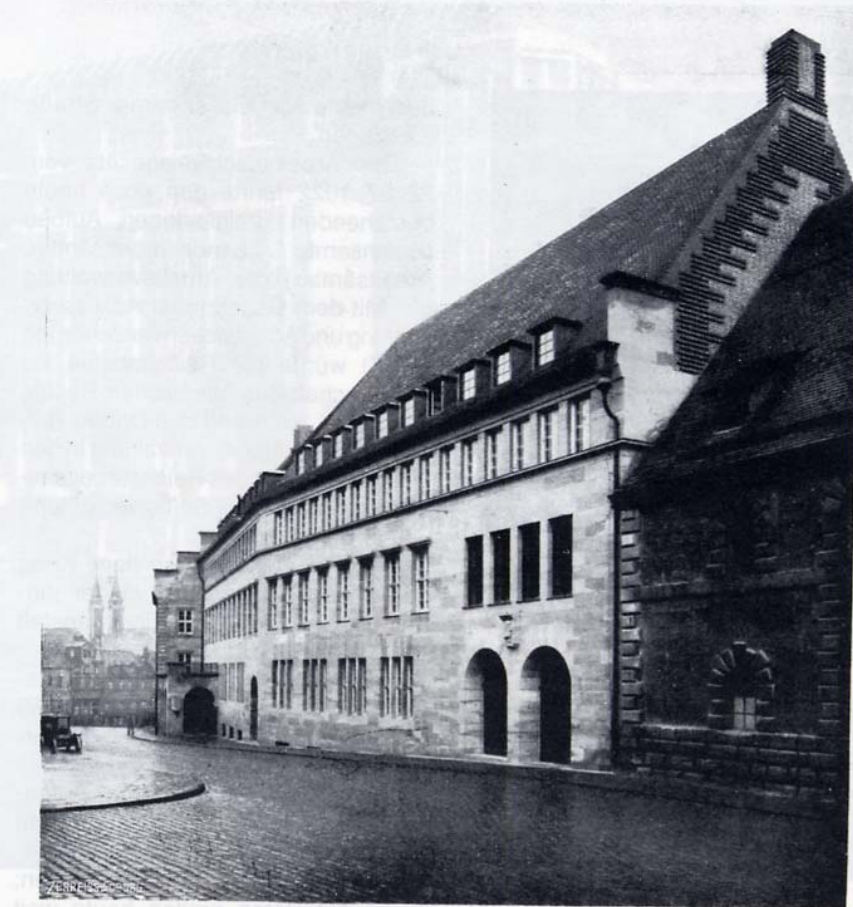
Gesamtansicht des Neubaus von der Waizenstraße aus
